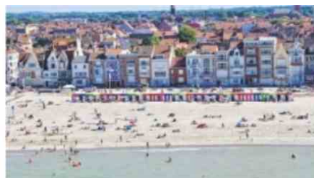
La belle plage de Malo les Bains a vu sa digue entièrement restaurée. J. L. Burnod
