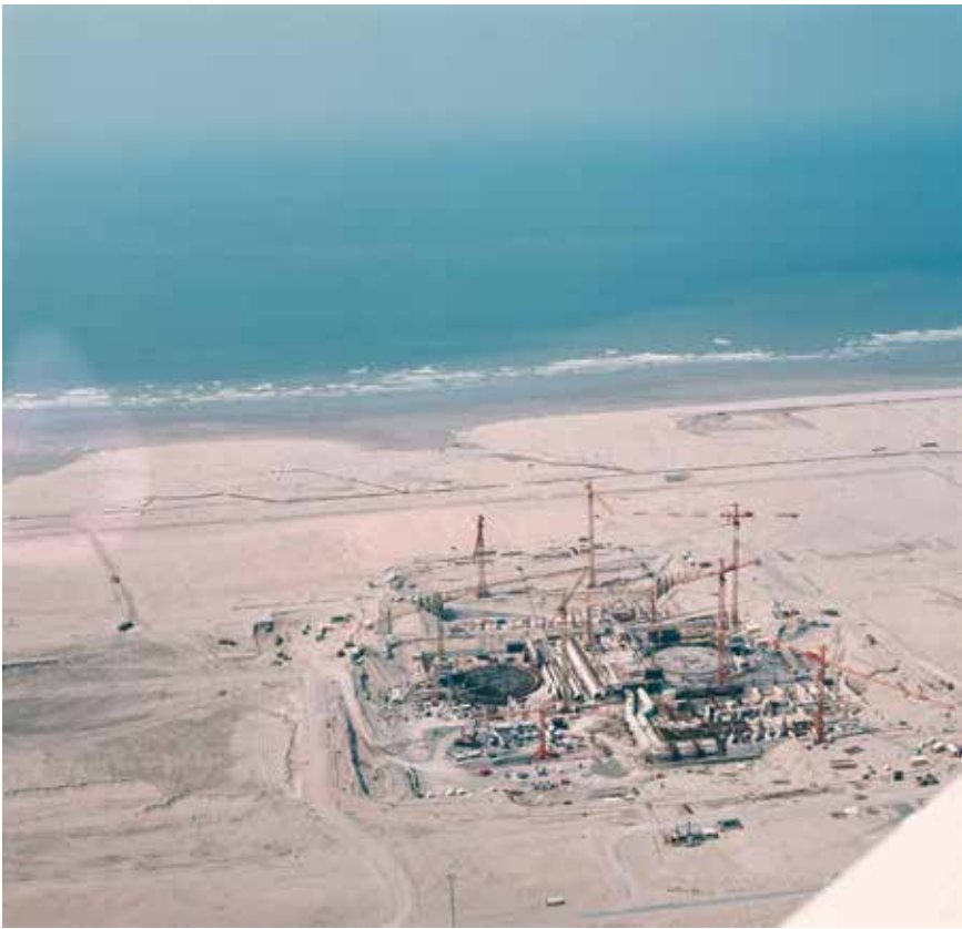
Jacques Bernard, Gravelines - Centrale nucléaire en construction : 1973, 1975 , film inversible couleur., 80 × 80 cm. Collection LAAC, Ville de Dunkerque © ADAGP, Paris, 2023.
