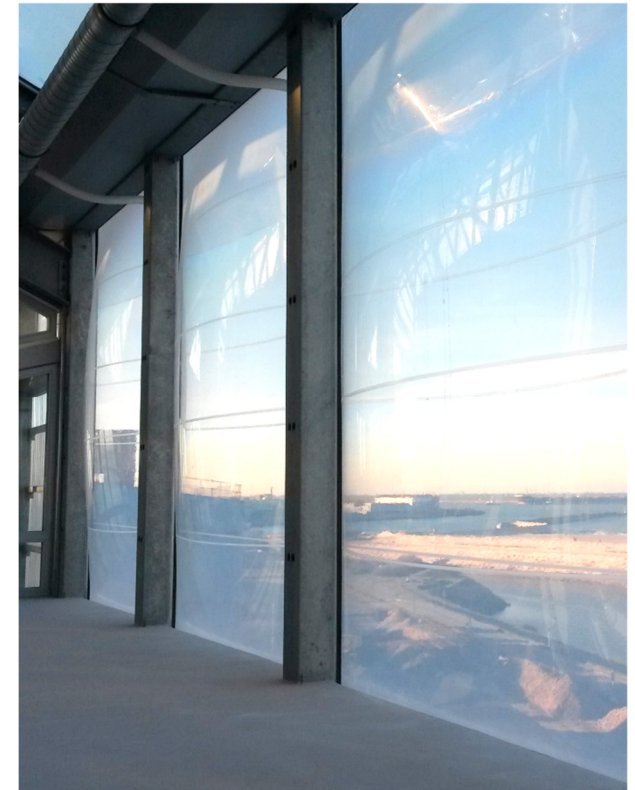
Vue de l'intérieur du Belvédère (dernier niveau du Frac). Coussins en téflon transparent comme matériaux séparant l'espace intérieur de l'espace extérieur.
