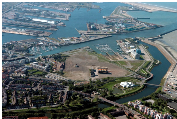
Images aériennes présentant le site des chantiers de France vide après son démantèlement.
