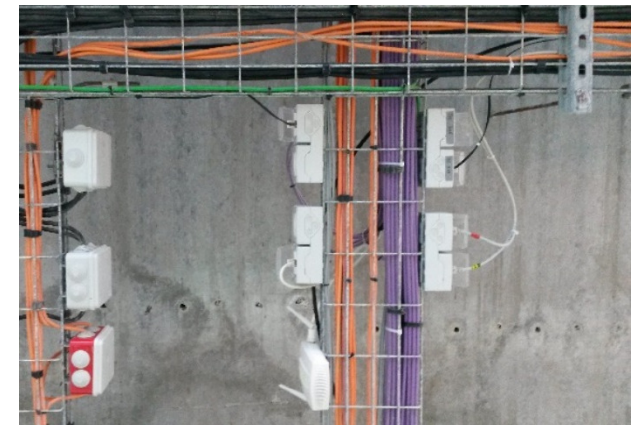
Vue d'un des plafonds. Tous les éléments techniques sont laissés apparents.
