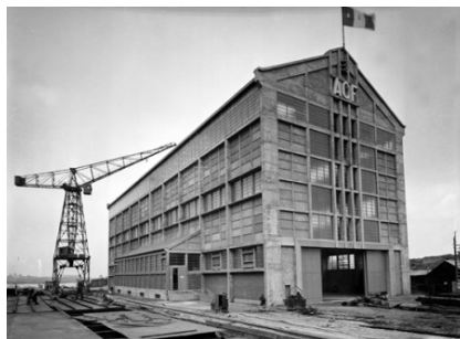
AP2, l'atelier de préfabrication n°2, surnommé la « Cathédrale » par les Dunkerquois, dimensions de l'AP2 : 75 mètres de long, 25 mètres de large, 25 à 30 mètres de haut.
